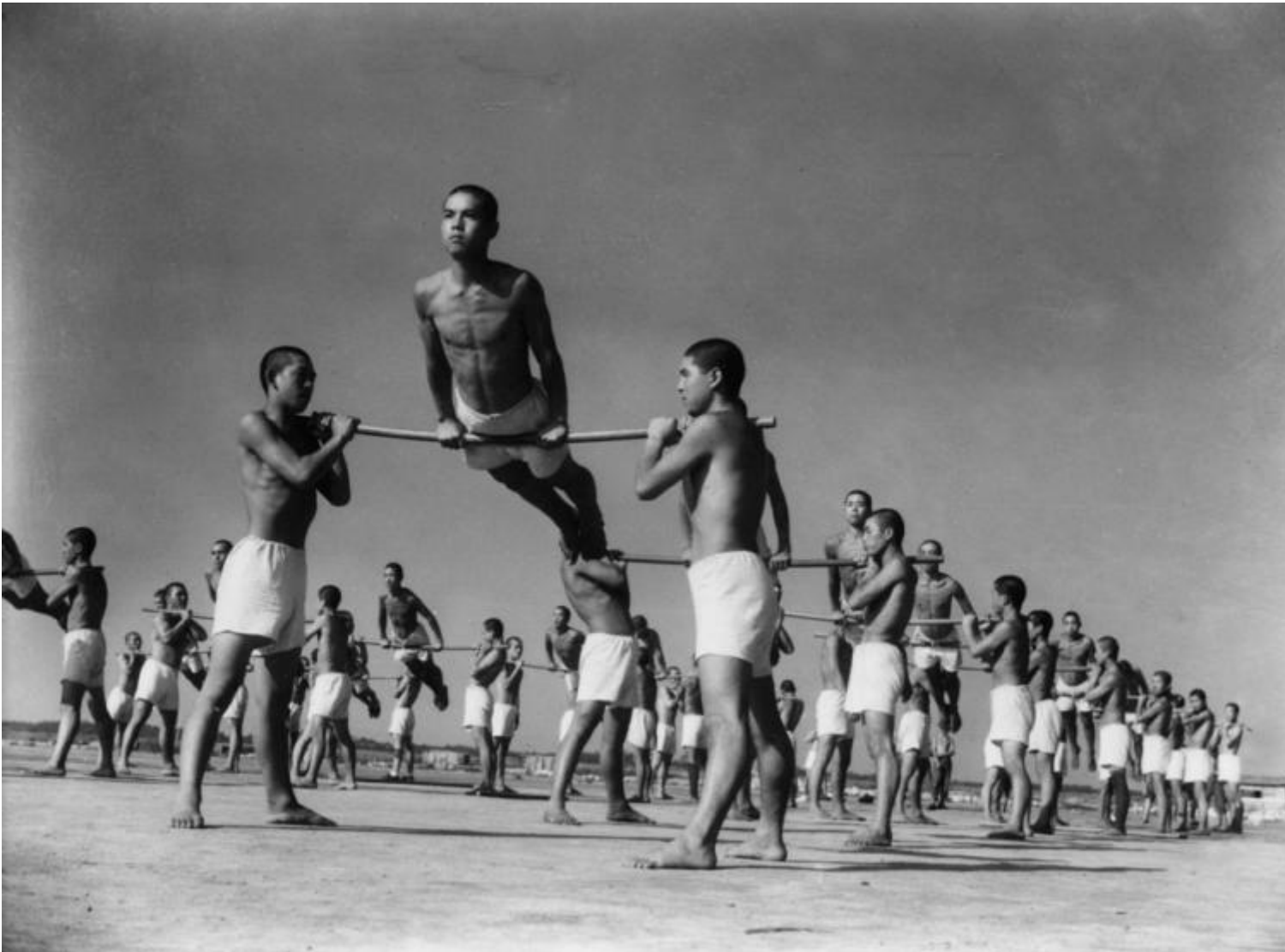
Allenamento degli allievi del corpo della Marina, 1936.
