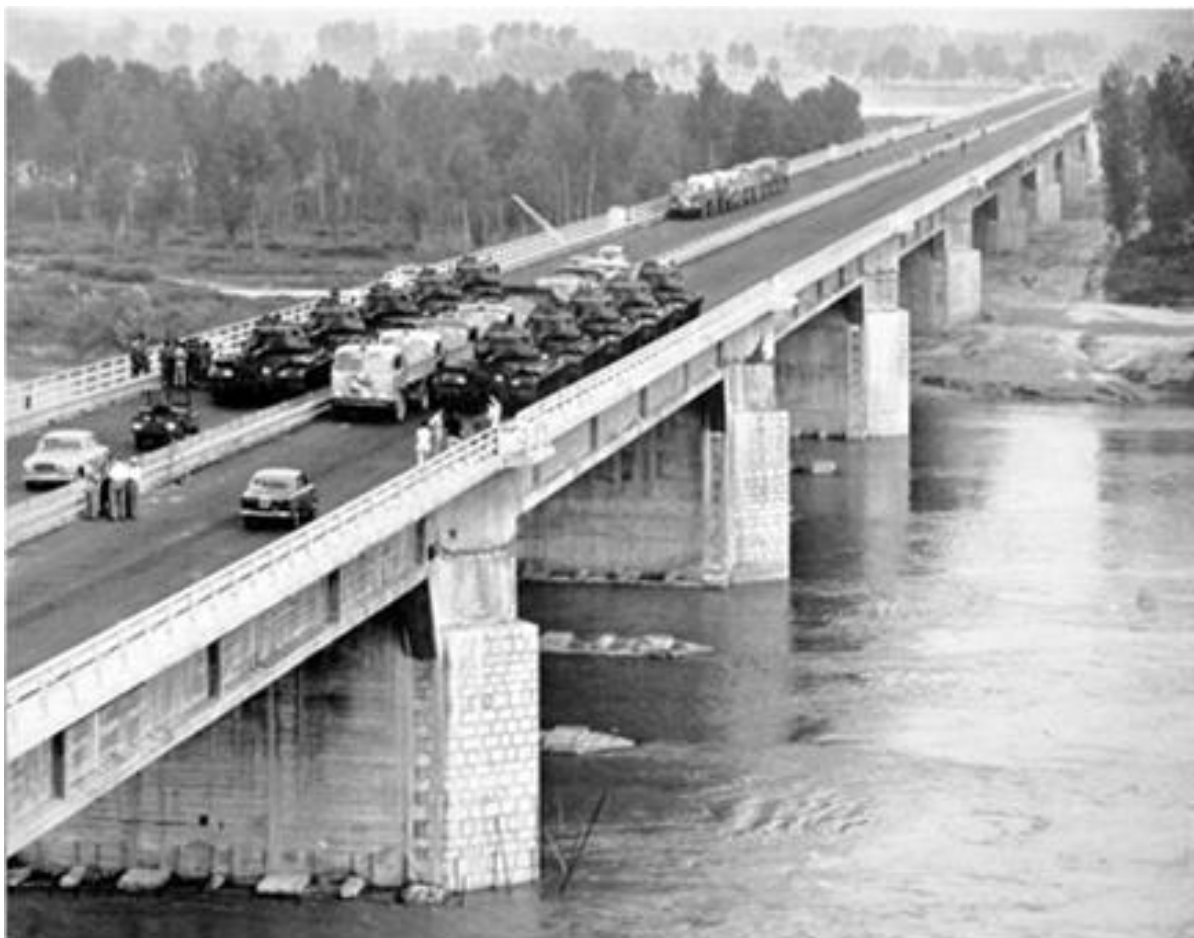
Ponte sul Po presso Piacenza. Collaudo 4-5 giugno 1959.
