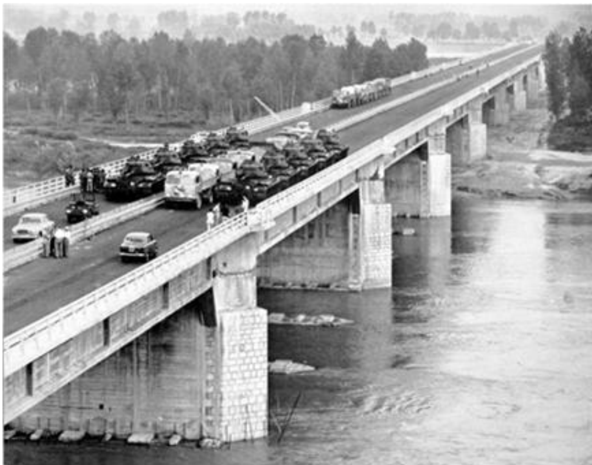
Ponte sul Po presso Piacenza. Collaudo 4-5 giugno 1959.
