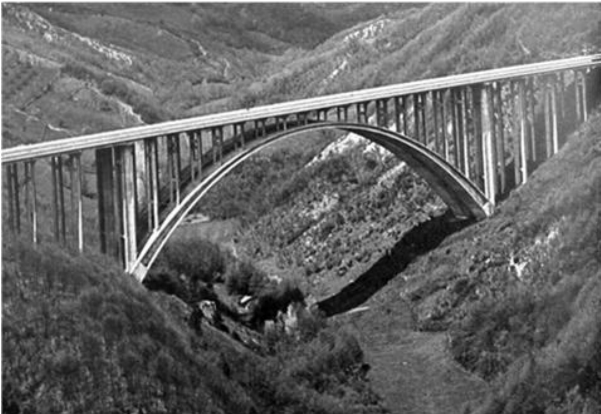
Viadotto sul torrente Aglio, G. Oberti, B. Gentilini, A. Romagnoli. 1957-1959, 164 metri di luce.
