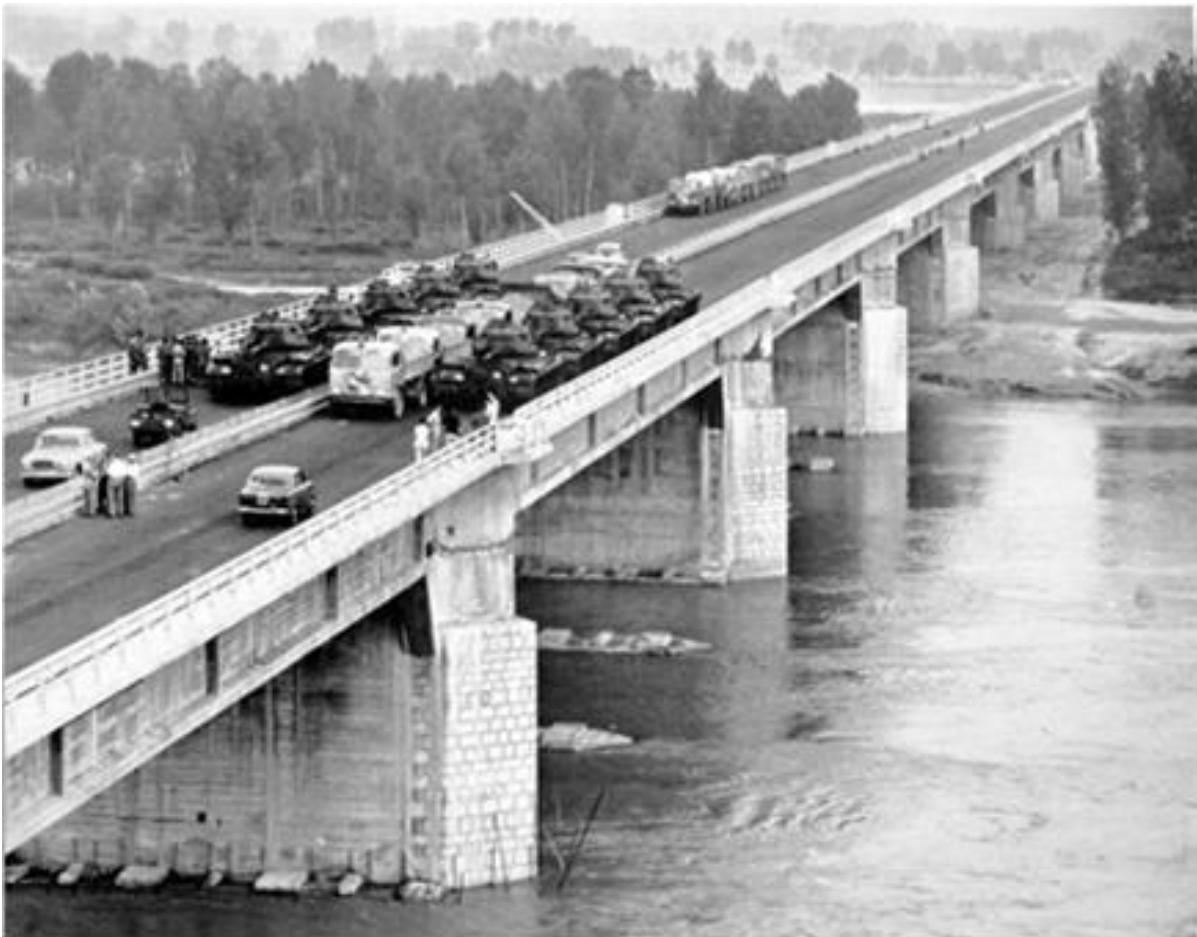
Ponte sul Po presso Piacenza. Collaudo 4-5 giugno 1959.
