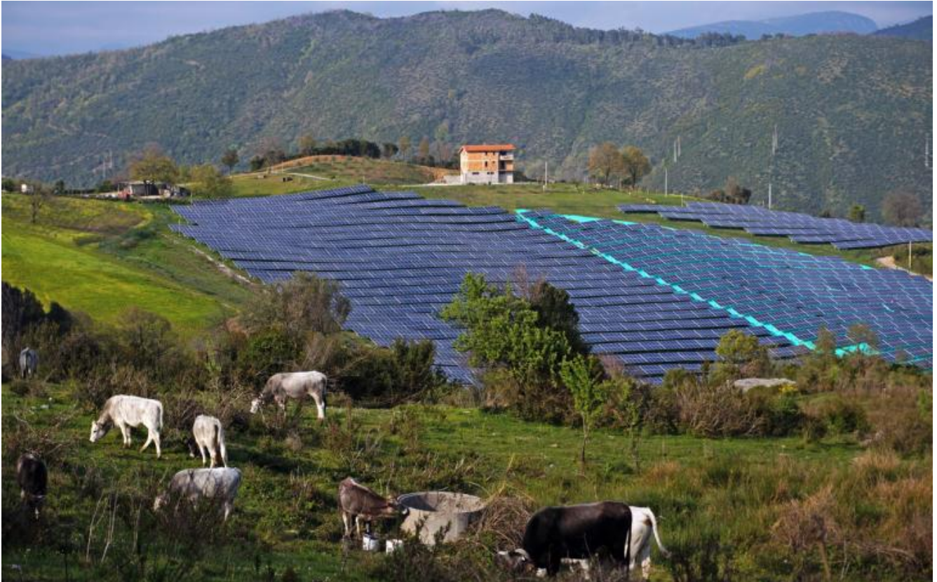
Salendo al rifugio del contadino tra i campi di fannelli fotovoltaici e mucche al pascolo.
