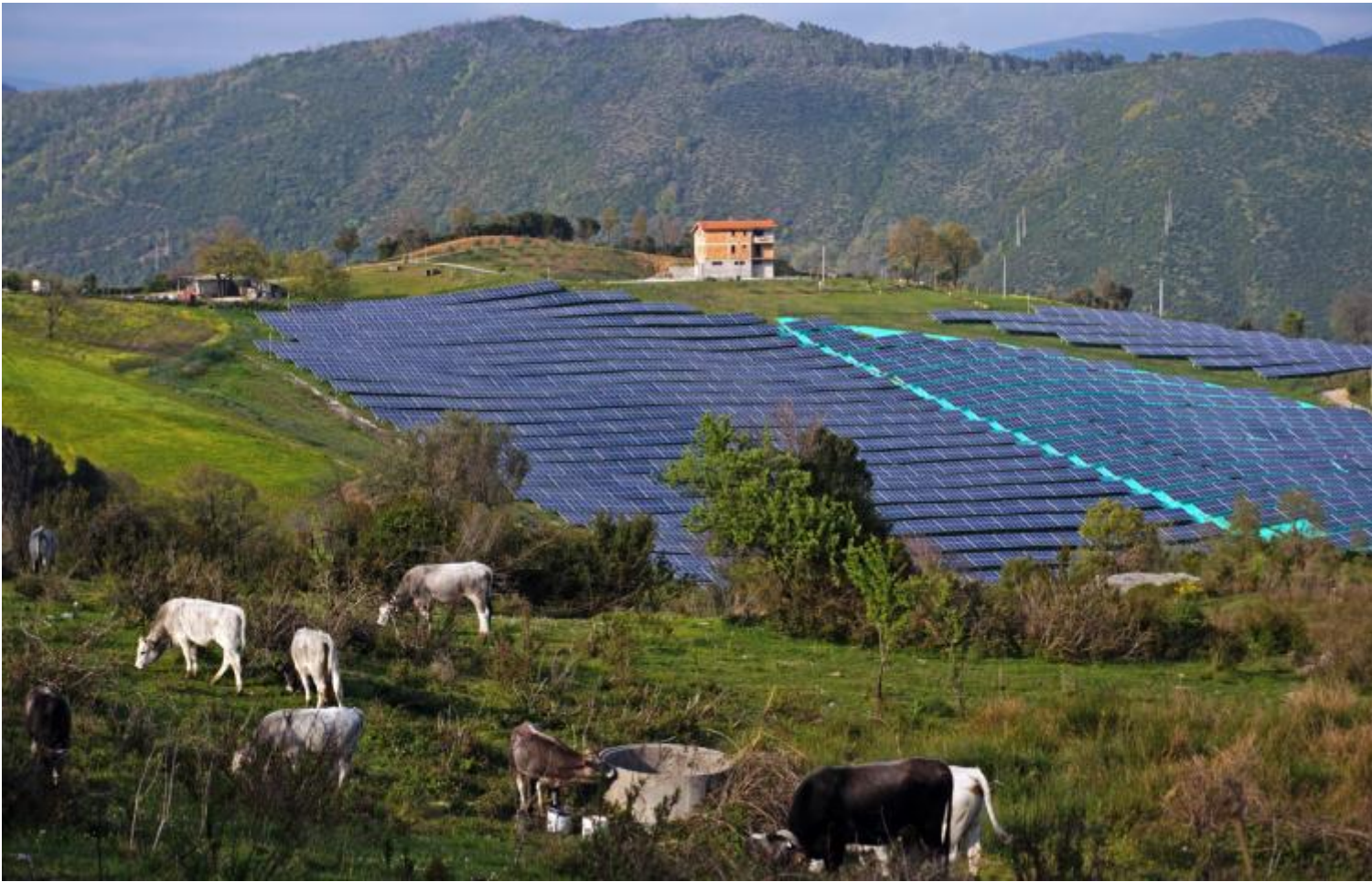
Salendo al rifugio del contadino tra i campi di fannelli fotovoltaici e mucche al pascolo.
