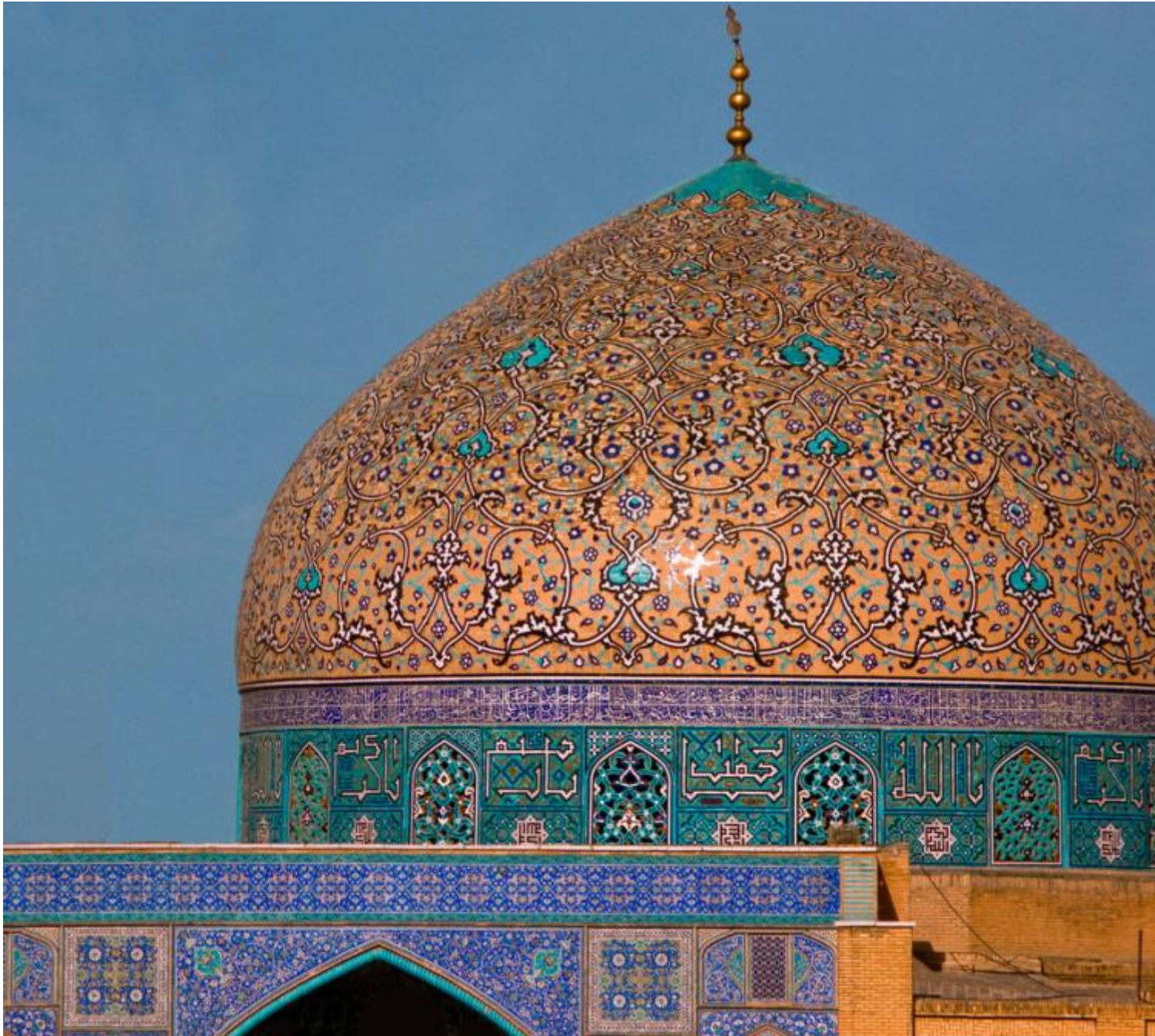
Cupola della moschea dello sceicco Lotfollah, Esfahan.
