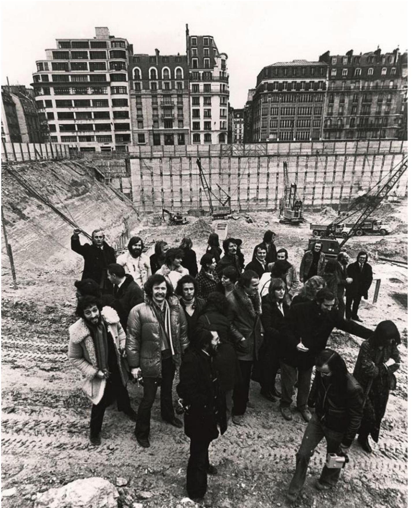
Renzo Piano, Richard Rogers e il loro team nel cantiere del Centre Pompidou, 1972. Studio Piano & Rogers. Fondazione Renzo Piano.
