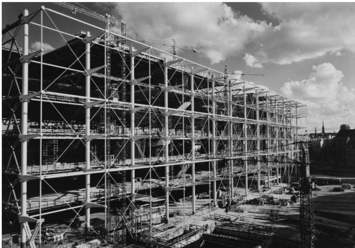
Il Centre Pompidou in costruzione. Parigi.
