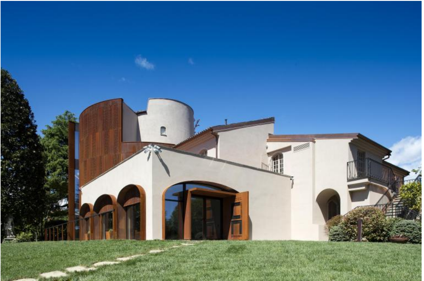
Villa Cerruti esterni.
