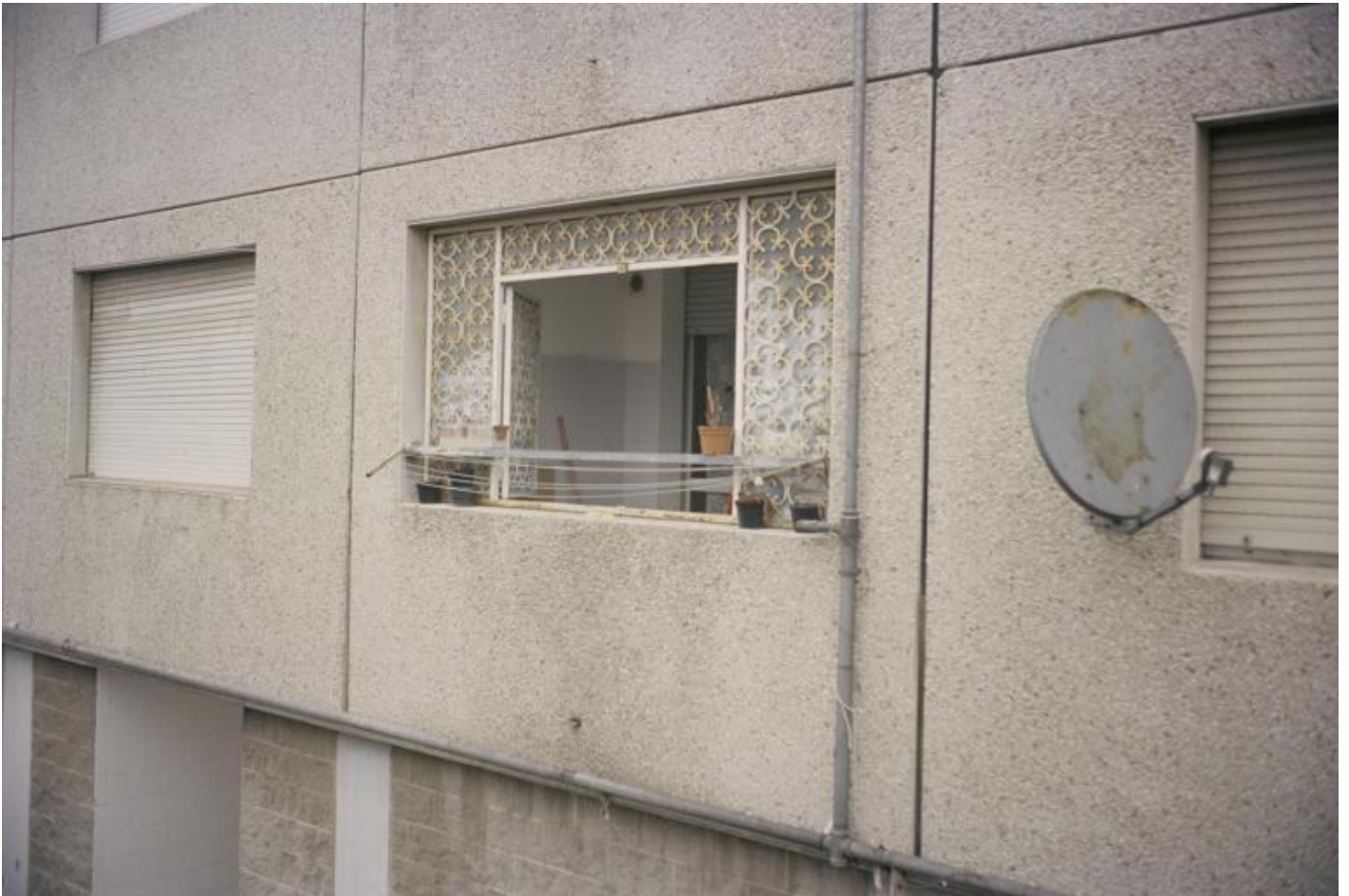
Finestra di un palazzo di edilizia popolare. Milano, Italia. 2018.
