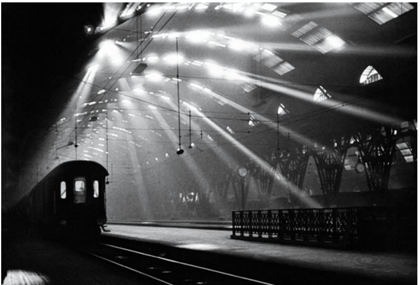
Pepi Merisio, Stazione centrale di Milano, 1953.
