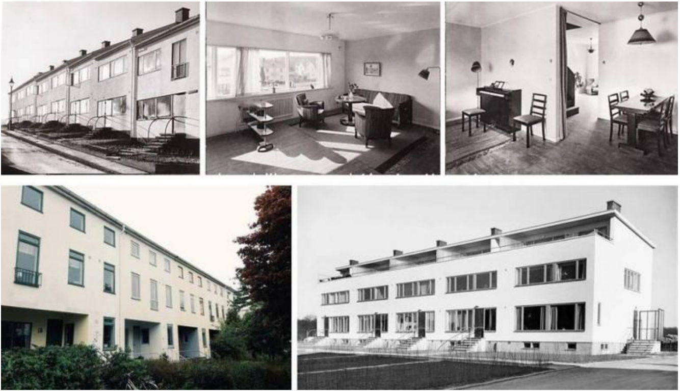
Ingrid Wallberg, i due interventi di case popolari a schiera a Göteborg, in Örgryte. In alto, 1934-1943, località Bö, veduta dell'esterno e dei luminosi interni. In basso: 1937-1943, a Bångejordsgatam.
