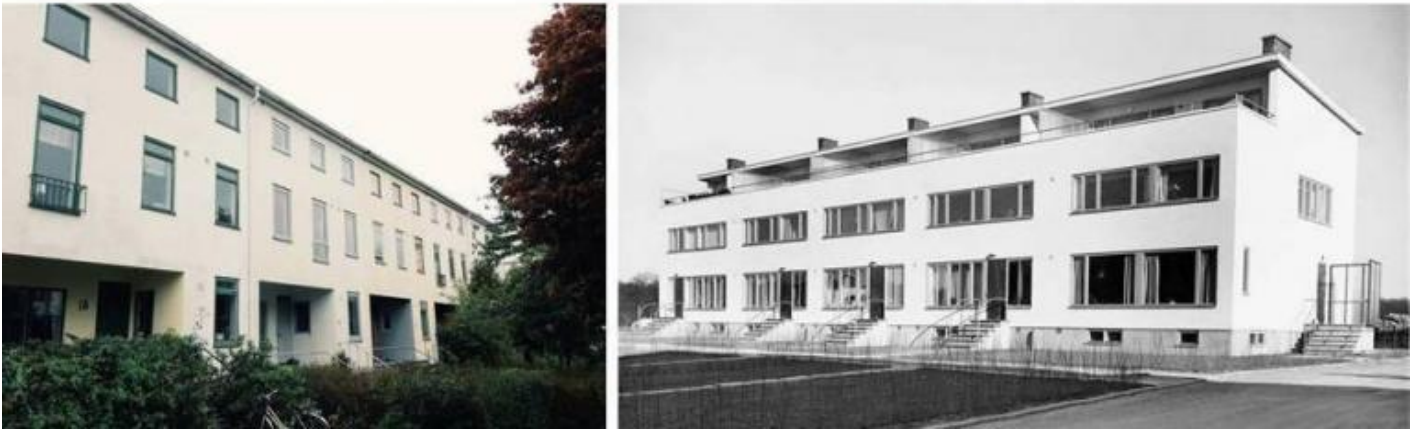
Ingrid Wallberg, i due interventi di case popolari a schiera a Göteborg, in Örgryte. In alto, 1934-1943, località Bö, veduta dell'esterno e dei luminosi interni. In basso: 1937-1943, a Bångejordsgatan.
