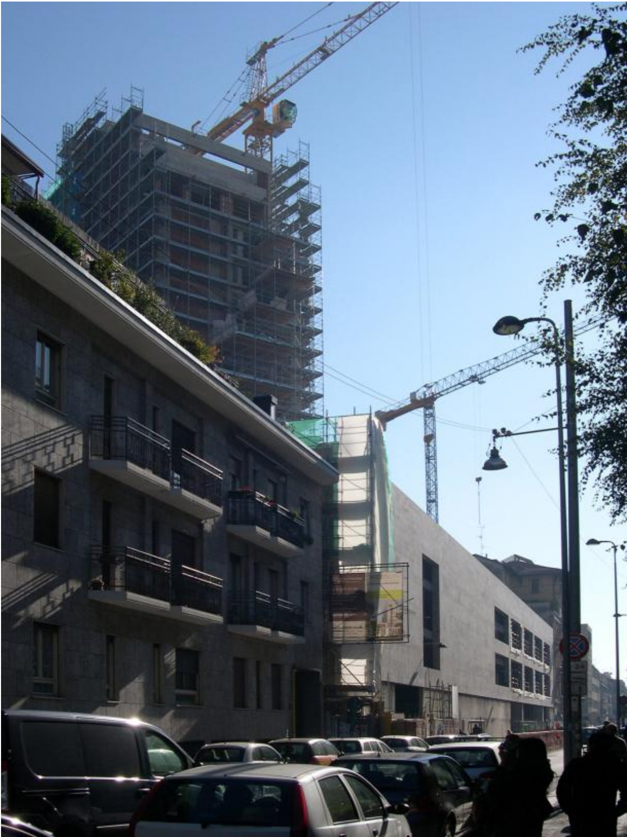
L'intervento in fase di realizzazione, Milano 2010
