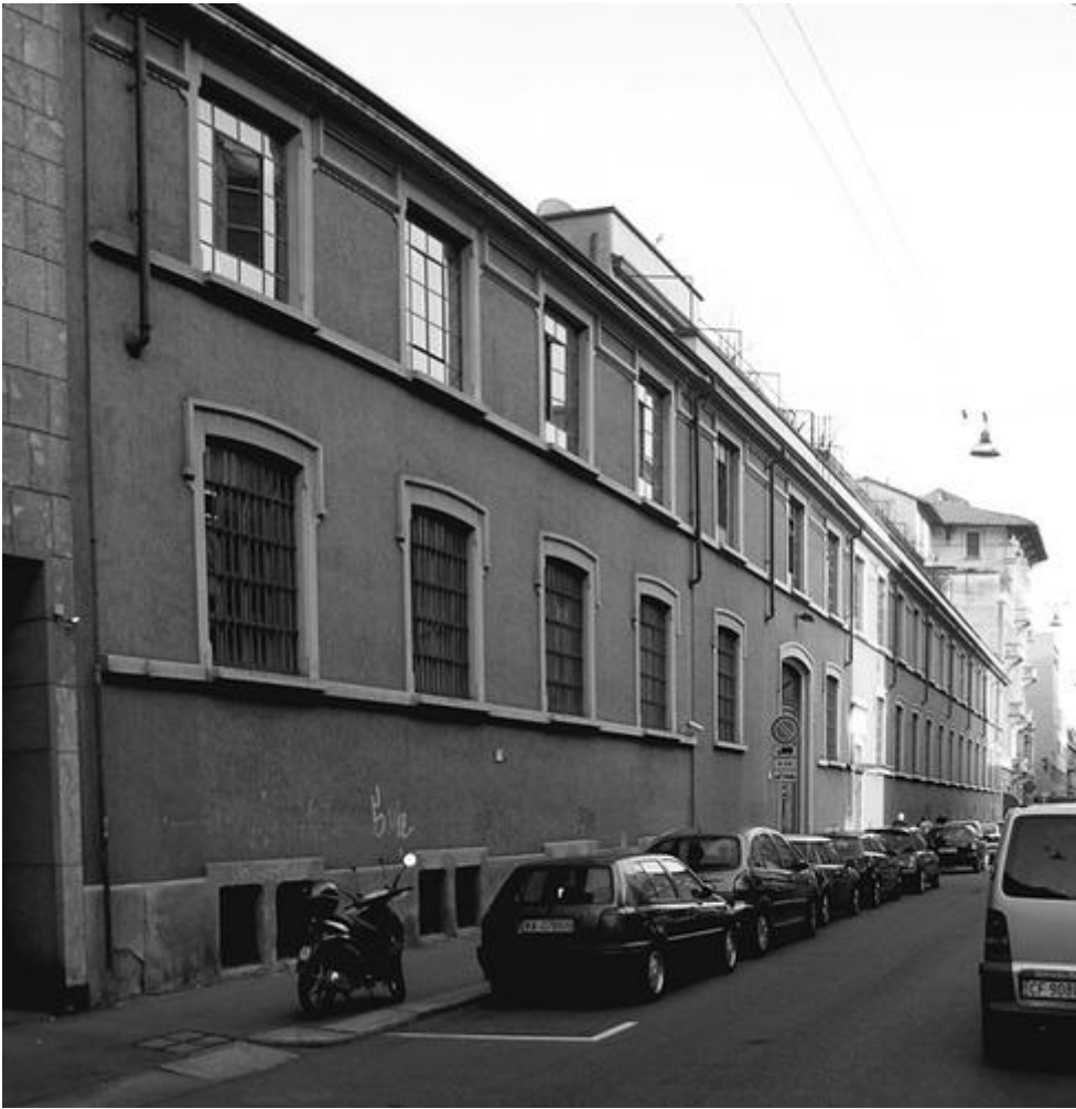
Lo stabilimento Centenari Zinelli di via Lomazzo prima della demolizione
