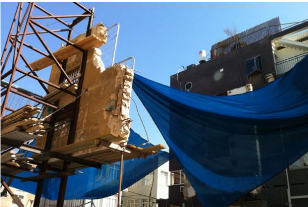
Un cantiere di muri sospesi a Jaffa
