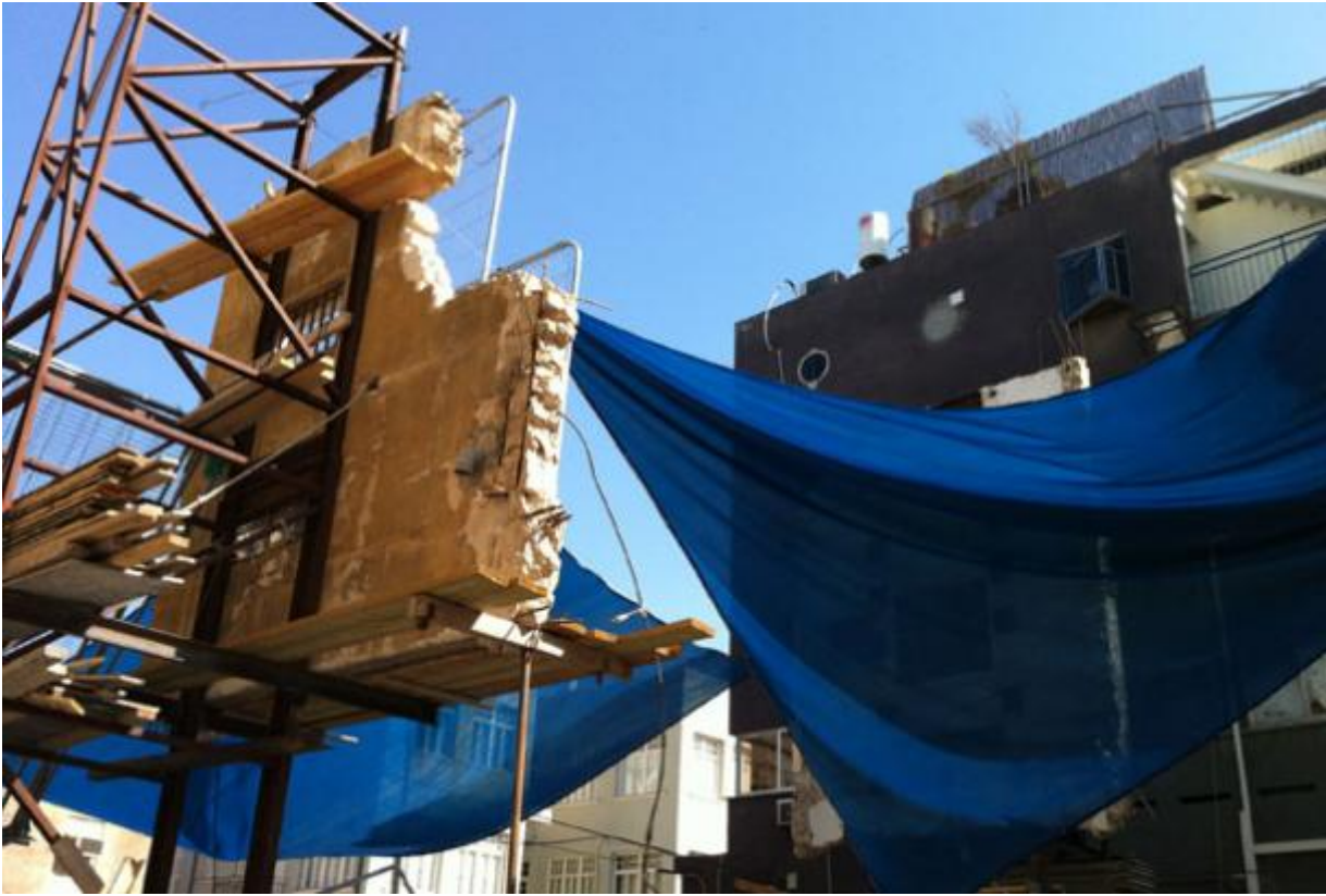
Un cantiere di muri sospesi a Jaffa
