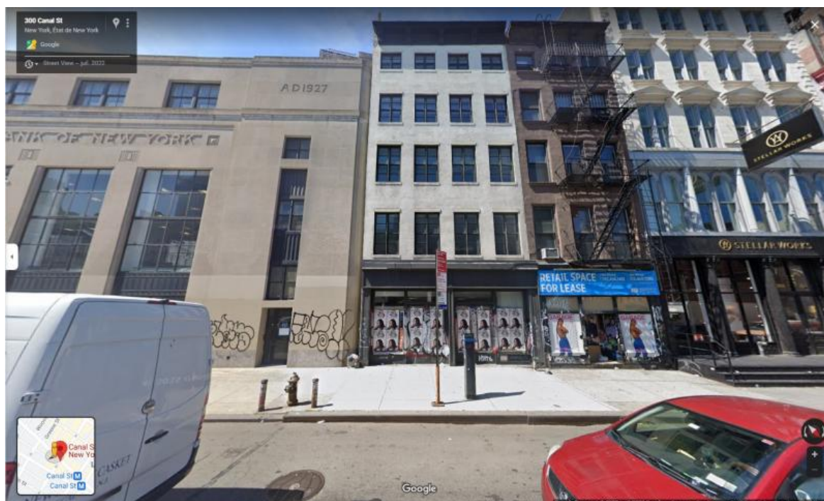
L'esterno dell'edificio in Canal Street dove, al secondo piano, si trovava il loft di Wavelength, come appare oggi su Google Maps.
