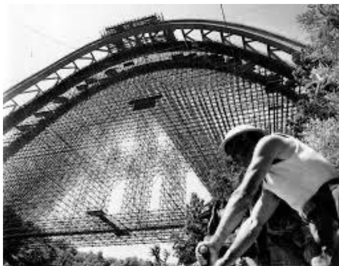
Domus: viadotto dell'Autostrada del Sole in costruzione
