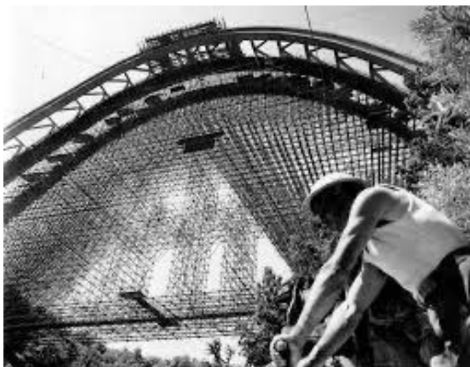
Domus: viadotto dell'Autostrada del Sole in costruzione
