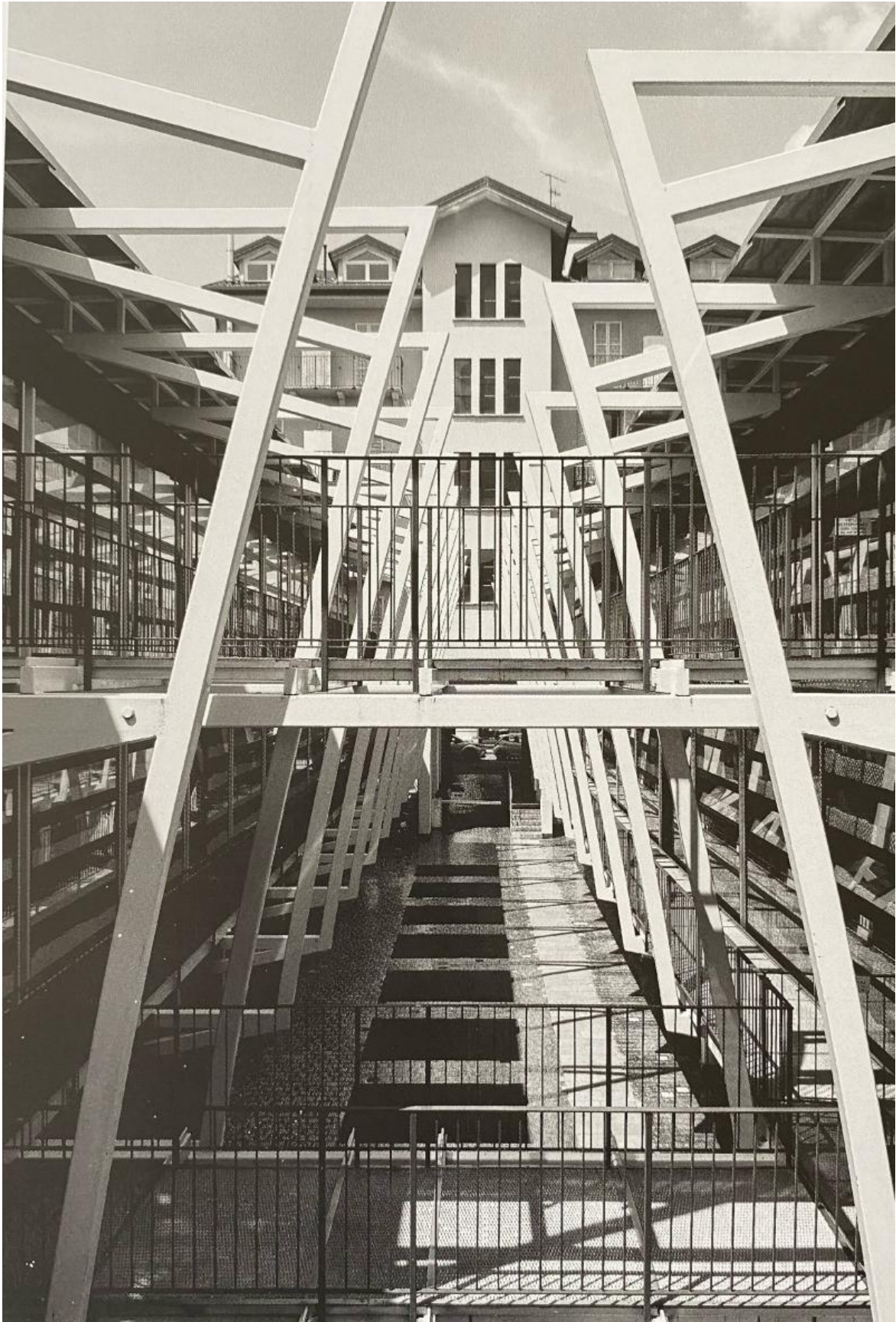
Interno della casa di Varese con l'adozione del cortile su progetto di Riccardo Blumer (ph Meazza).
