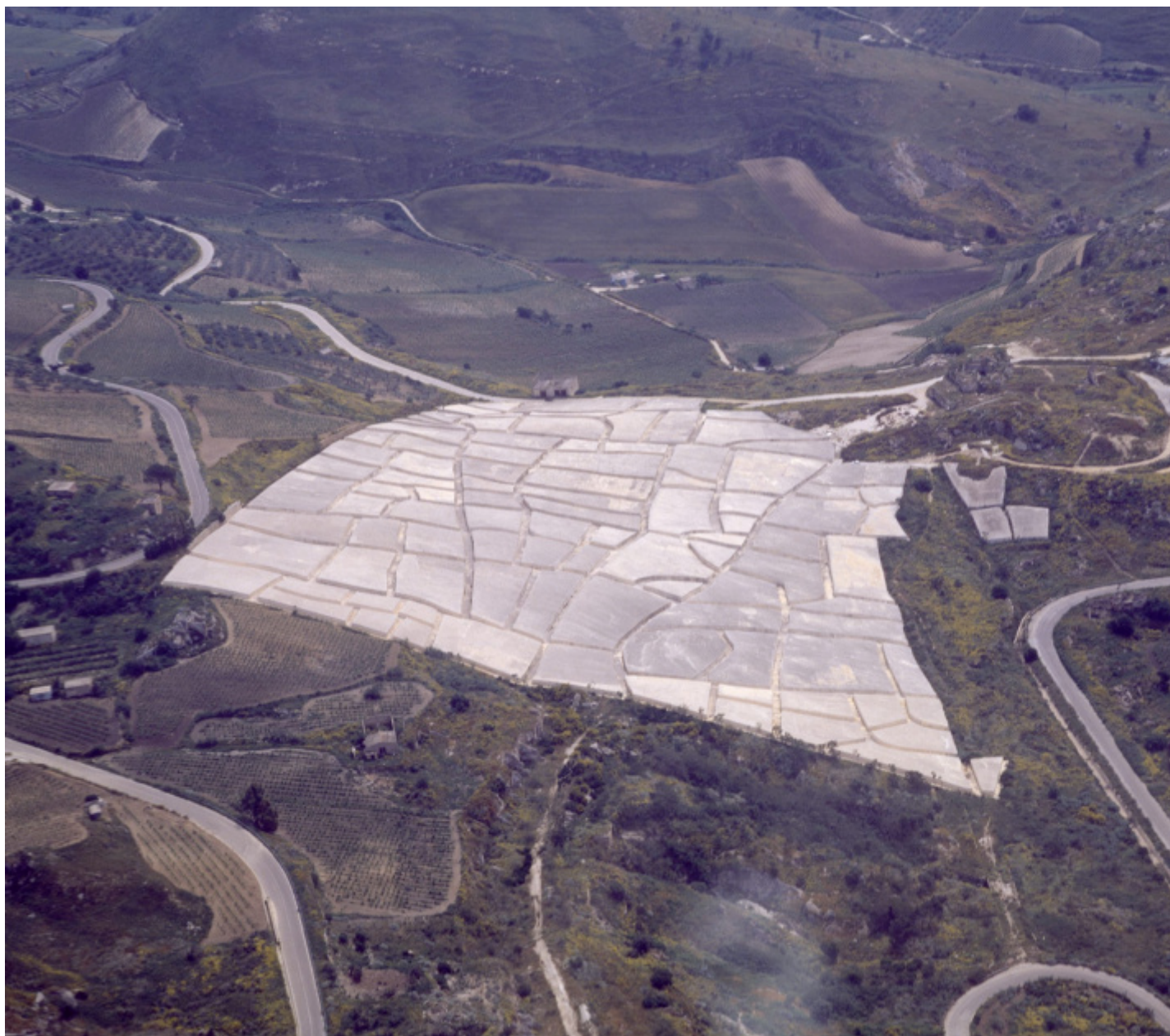
CRETTO DI GIBELLINA © Archivio Storico Luce Vittorugo Contino, Il Grande Cretto di Alberto Burri, Gibellina.
