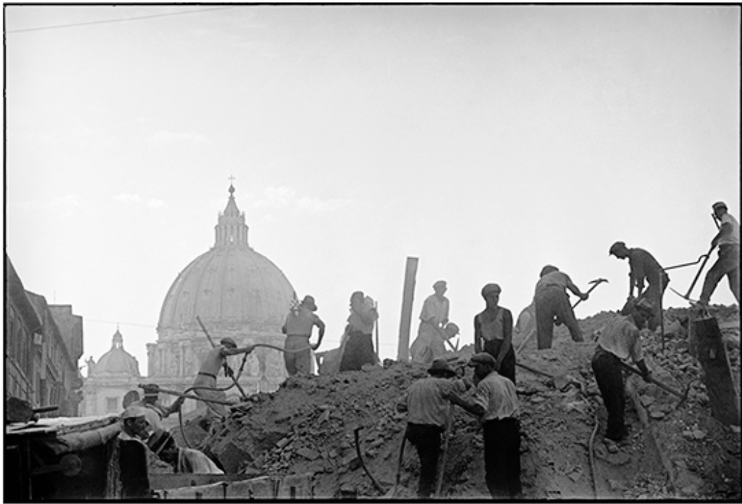
Roma, Operai in atto di demolire la Spina di Borgo, 1936/1937.
