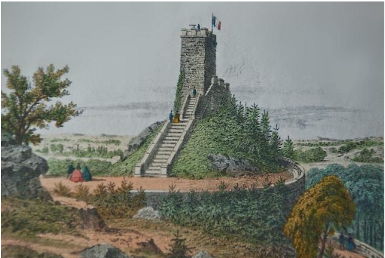
La Tour Denecourt, 1853, Forêt de Fontainebleau.
