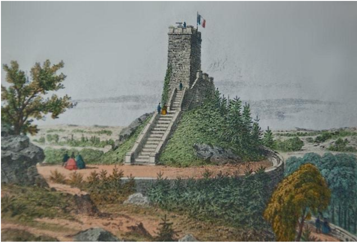
La Tour Denecourt, 1853, Forêt de Fontainebleau.
