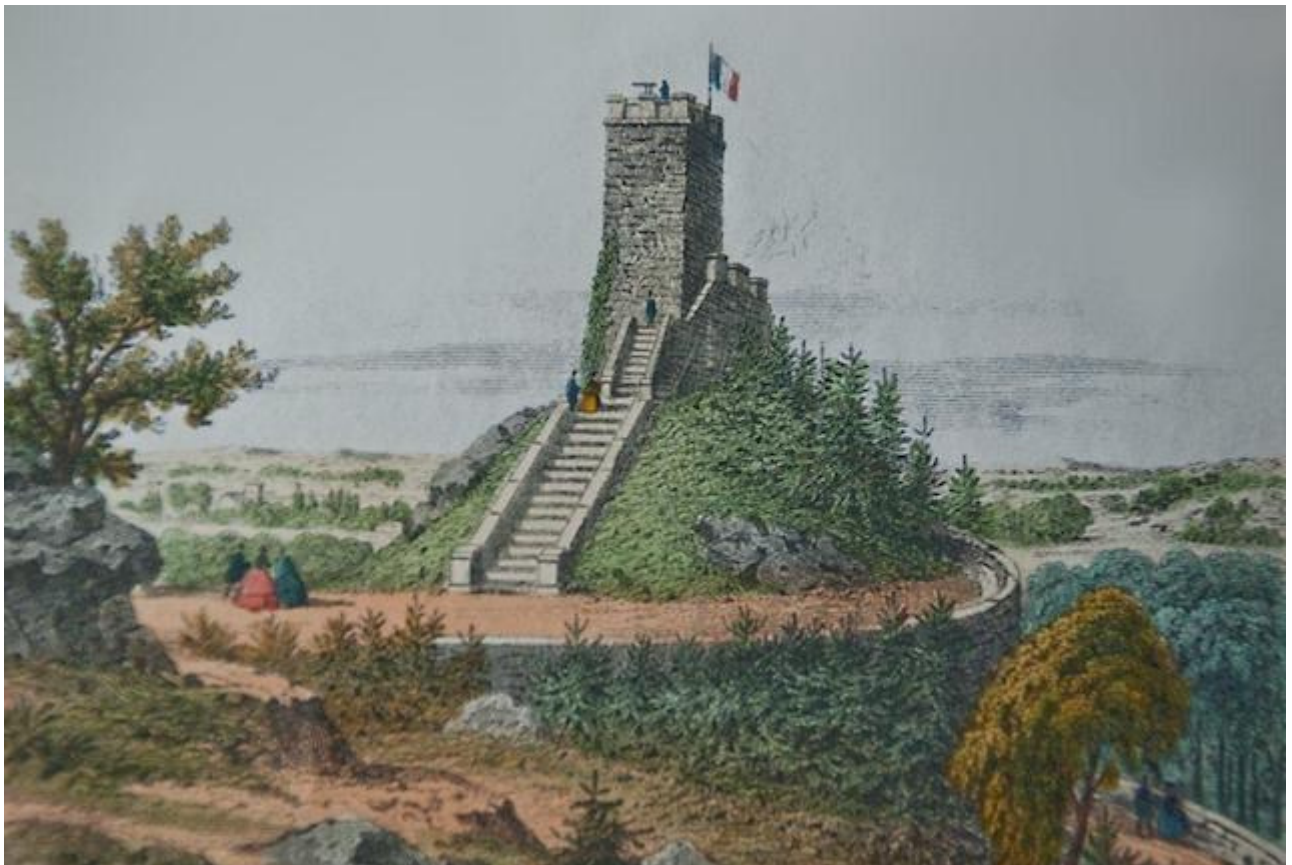
La Tour Denecourt, 1853, Forêt de Fontainebleau.
