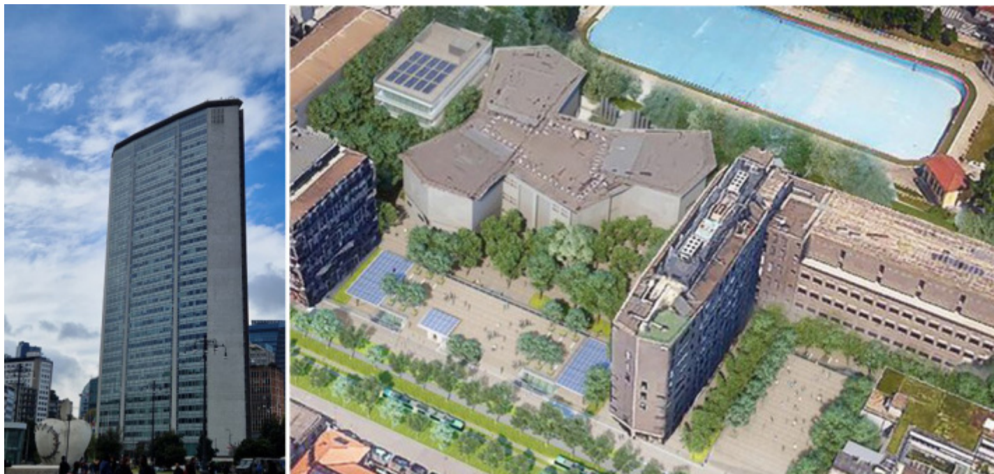
Gio Ponti, il Grattaciolo Pirelli (1960) con Pier Luigi Nervi ed altri; vista dall'alto del Trifoglio e della Nave , Facoltà di Architettura del Politecnico di Milano, con Giordano Forti (1953-1963).
