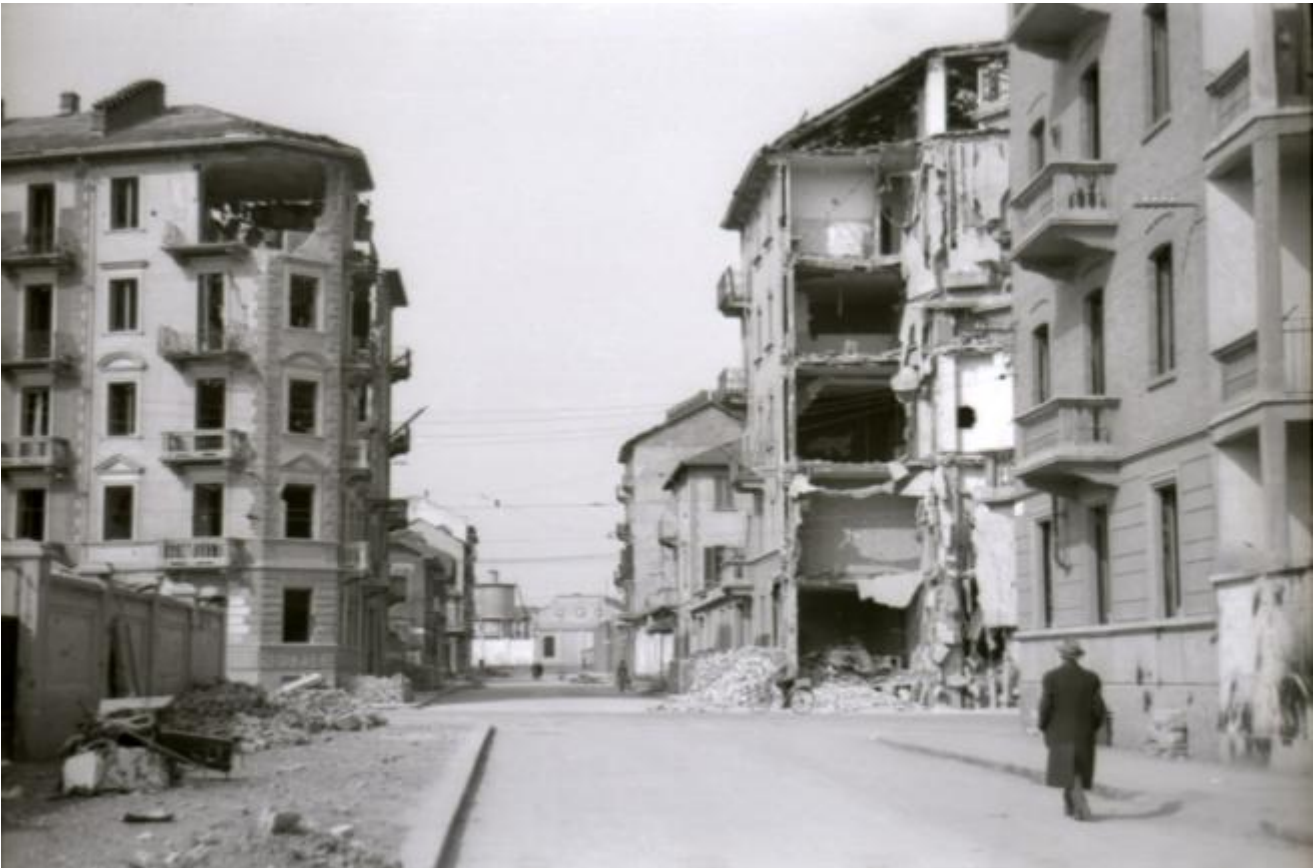
Via Vinadio a Torino, dopo un bombardamento, nel 1944. Sullo sfondo si vede il muro della Diatto, in quegli anni ormai SNIA Viscosa, e al di sopra del muro sventa, integra, la cisterna sulla quale è in corso la battaglia per evitare la demolizione della fabbrica da parte di Sniarischiosa un comitato di cittadini congiunto al coordinamento di Associazioni ambientaliste Italia Nostra, Legambiente Ecopolis e Pro Natura Torino.
