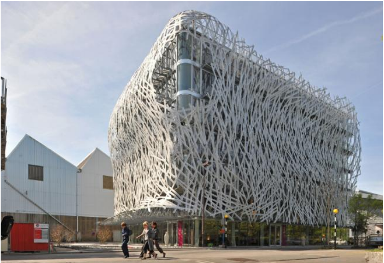
The Manny building in the Quartier de la Création
