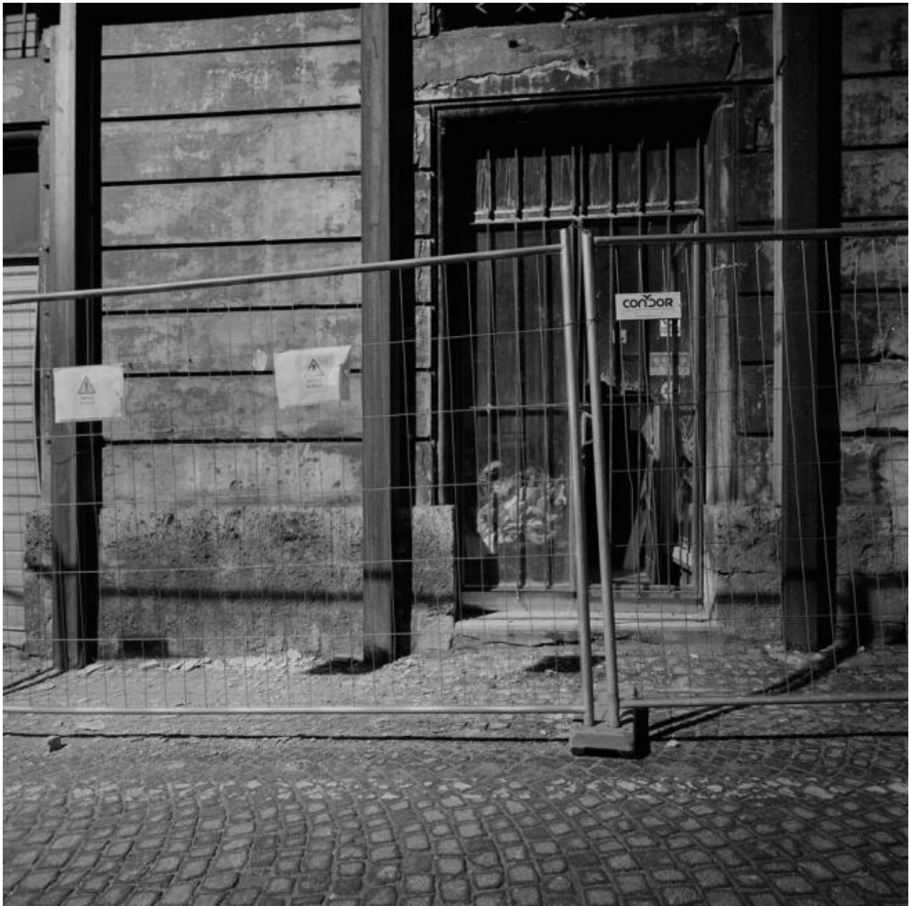
L'Aquila centro storico, novembre 2010
