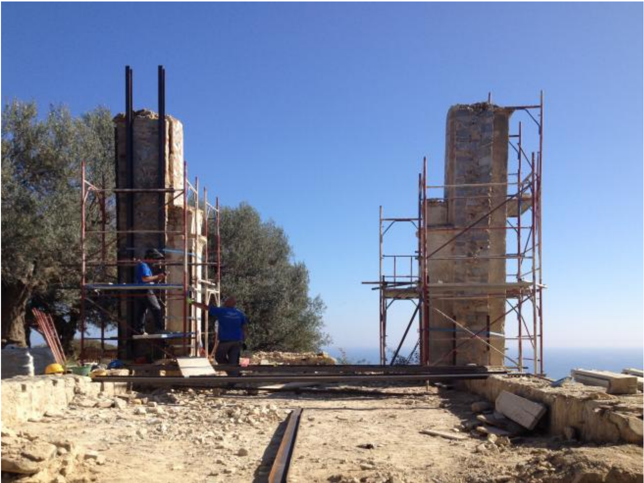
Cappella della Madonna del Carmine di Montegiordano, il cantiere nello stato attuale
