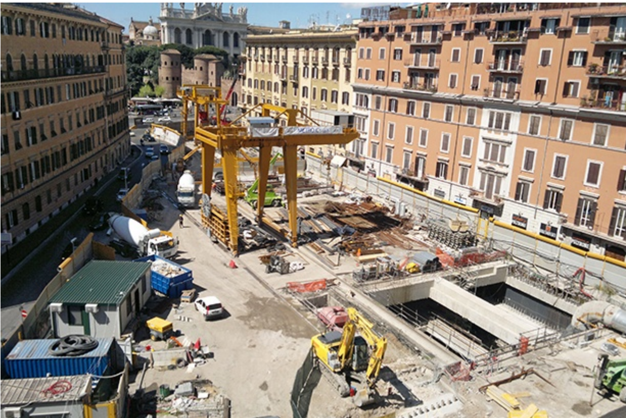
Roma, cantiere della Linea C
