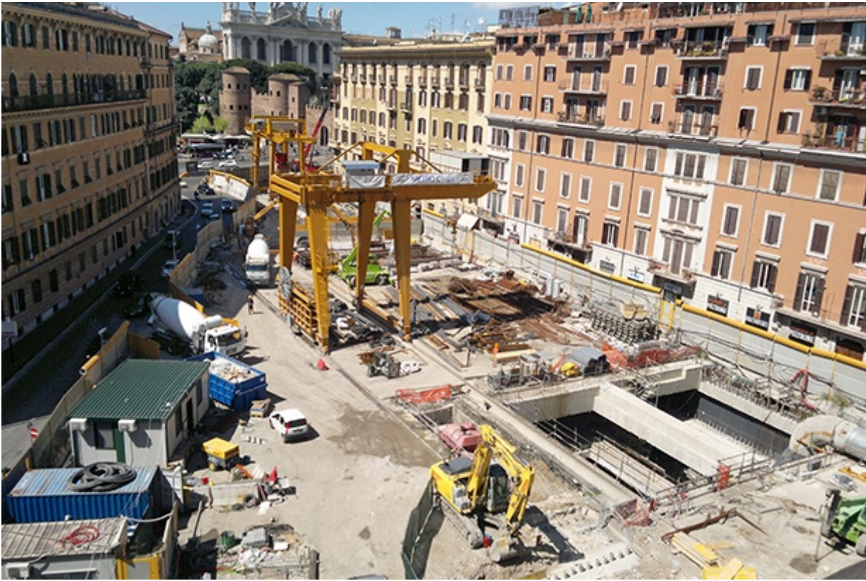
Roma, cantiere della Linea C
