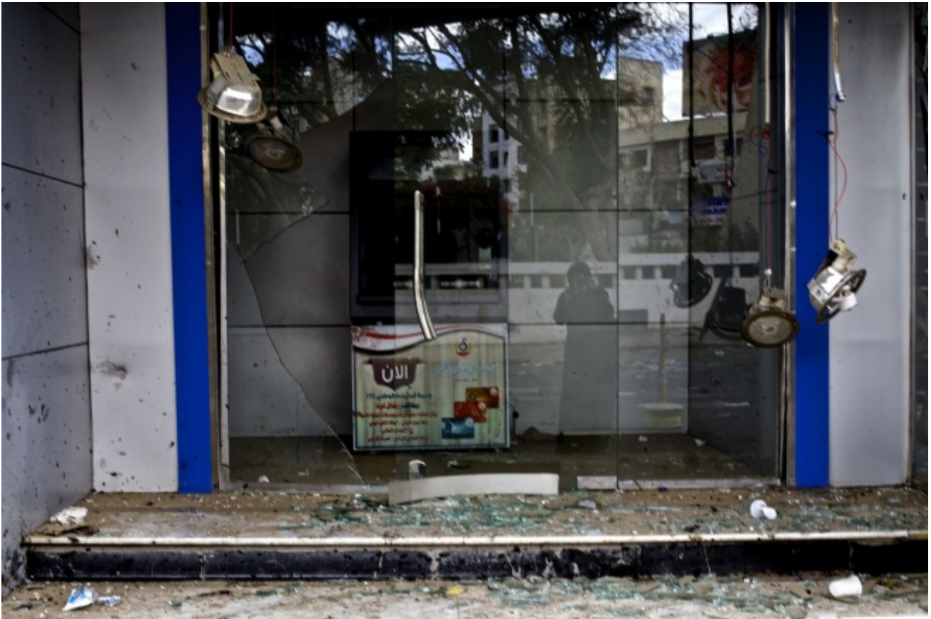
Sanaa, Yemen - Quel che rimane dell'ingresso della Islamic Bank in piazza Tahrir dopo l'attacco suicida del 9 ottobre 2014
