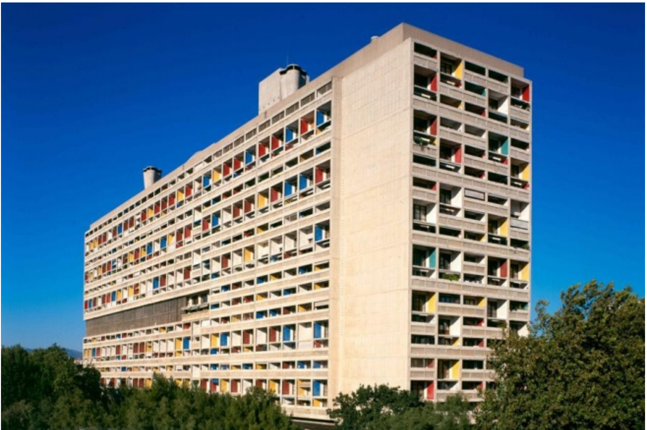
Unité d'Habitation, Marsiglia, progetto di Le Corbusier, 1952. Foto tratta da Fondation Le Corbusier
