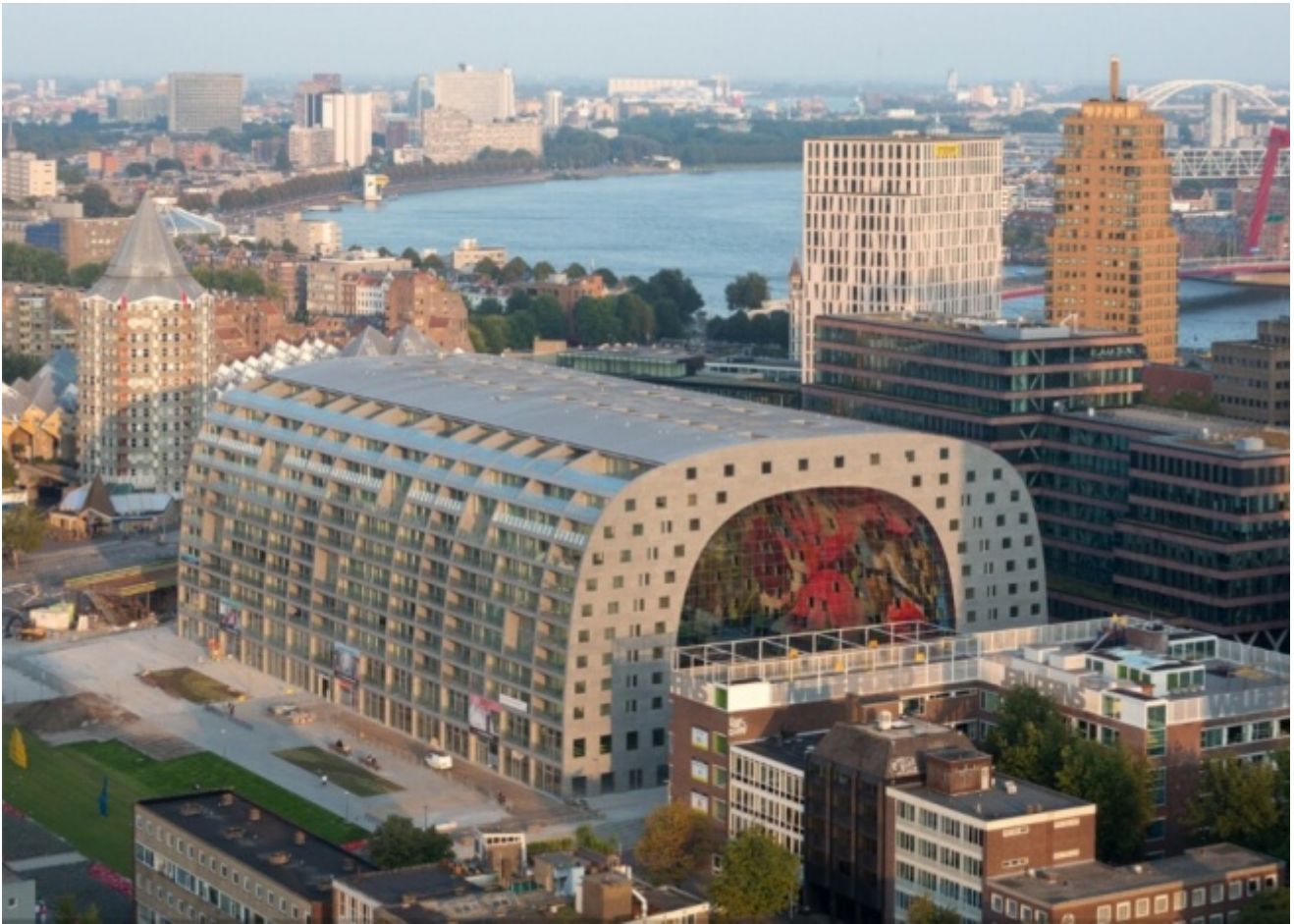
Market Hall di Rotterdam progetto degli MVRDV, 2004-2014
