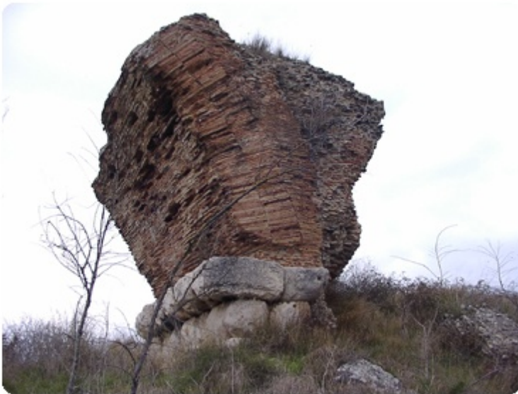
Rudere di un pilone del ponte romano che scavalcava il fiume Miscano con una sola arcata, denominato Ponte del Diavolo
